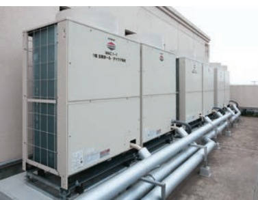
省エネ性能の高い日立ジョンソンコントロールズ空調製個別空調システムの室外機。
